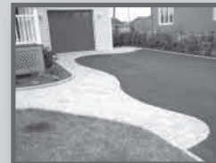
Pavage, interbloc et muret
