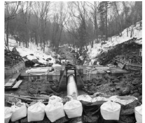
Des travaux majeurs de réfection du barrage ont été réalisés par la Ville. La structure nécessitait une intervention pour assurer la pérennité de l'ouvrage. Gilles Hardy devrait maintenant avoir la tâche un peu simplifiée dans le contrôle du niveau d'eau puisque le lac s'écoulera désormais naturellement par le dessus du barrage. Bien entendu, il devra quand même intervenir dans le cas de crues importantes.
