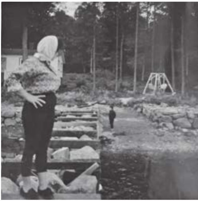
Construction du chalet de mes parents
