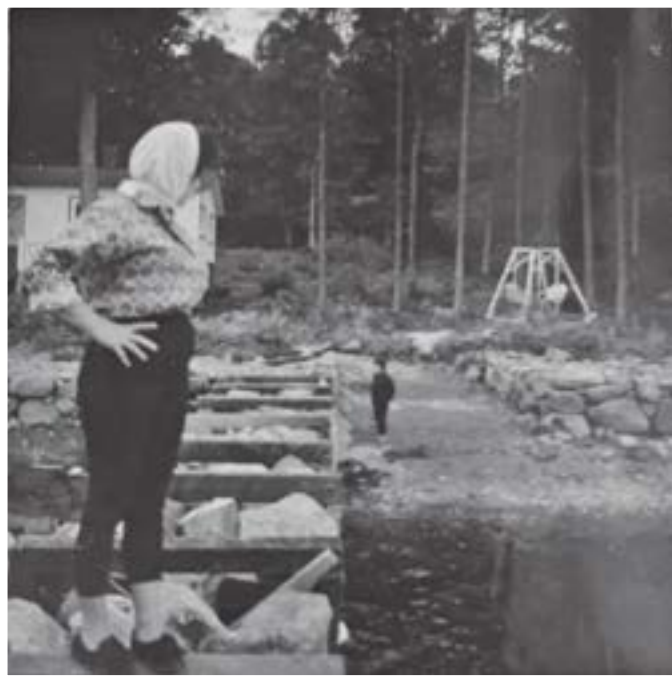
Construction du chalet de mes parents
